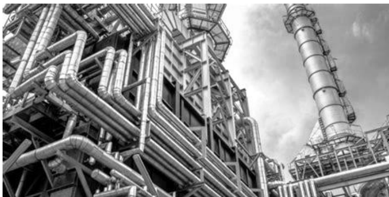
Terwijl het product in abstracte termen 'energie' of 'data' heet, is de materiële verschijningsvorm van de productie metallurgisch in het exterieur en in het interieur. Evenals de verdere toebehoren voor deze producten. (foto: waterstoffabriek)
